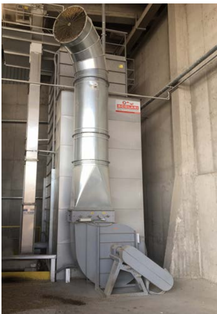
→ Le refroidisseur est associé au toasteur en sortie de machine afin de diminuer la température du grain.
