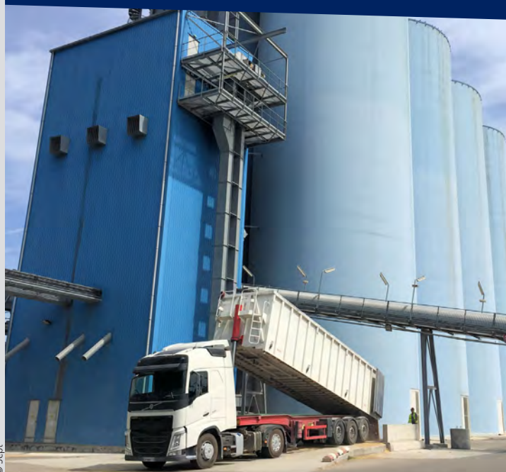
→ Les silos verticaux ont une capacité de stockage de 66 000 t.
