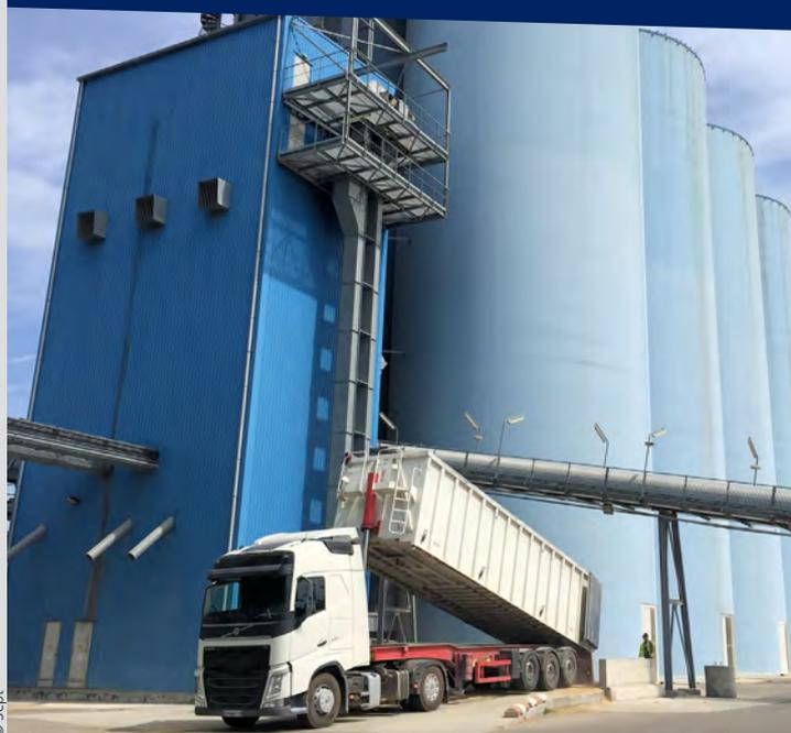
→ Les silos verticaux ont une capacité de stockage de 66 000 t.
